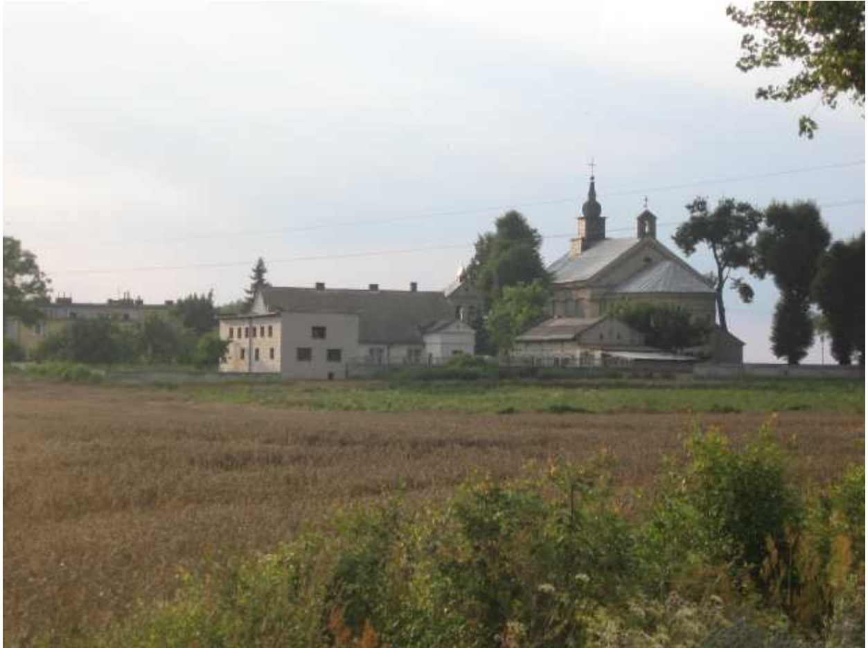
Widok na Broniewo od strony północno-zachodniej
