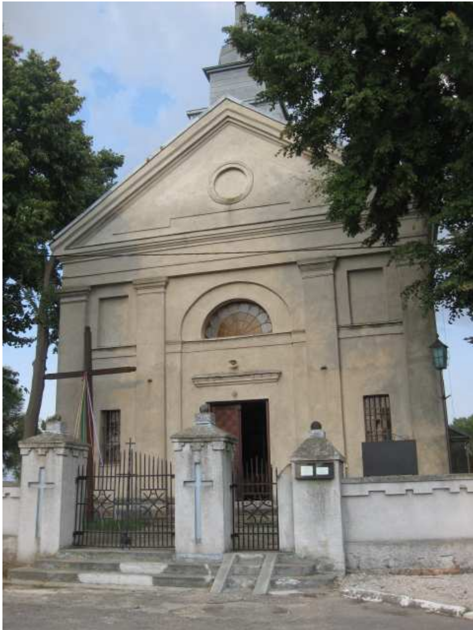
Wejście do kościoła od frontu
